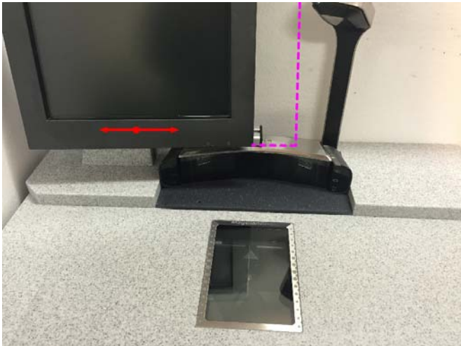
Linksablauf Scanner Mitte
